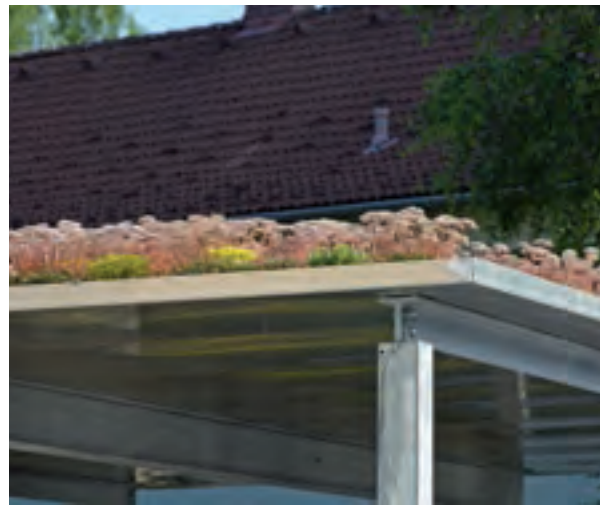
Begrüntes Dach über einem Carport mit Bewuchs aus Weißem und Mildem Mauerpfeffer
