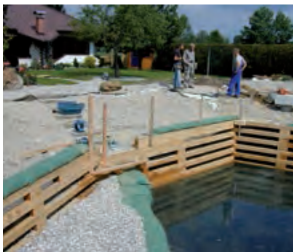
Abgrenzung zwischen Schwimmbereich und Regenerationszone durch eine Holzwand aus unbehandeltem Kantholz
