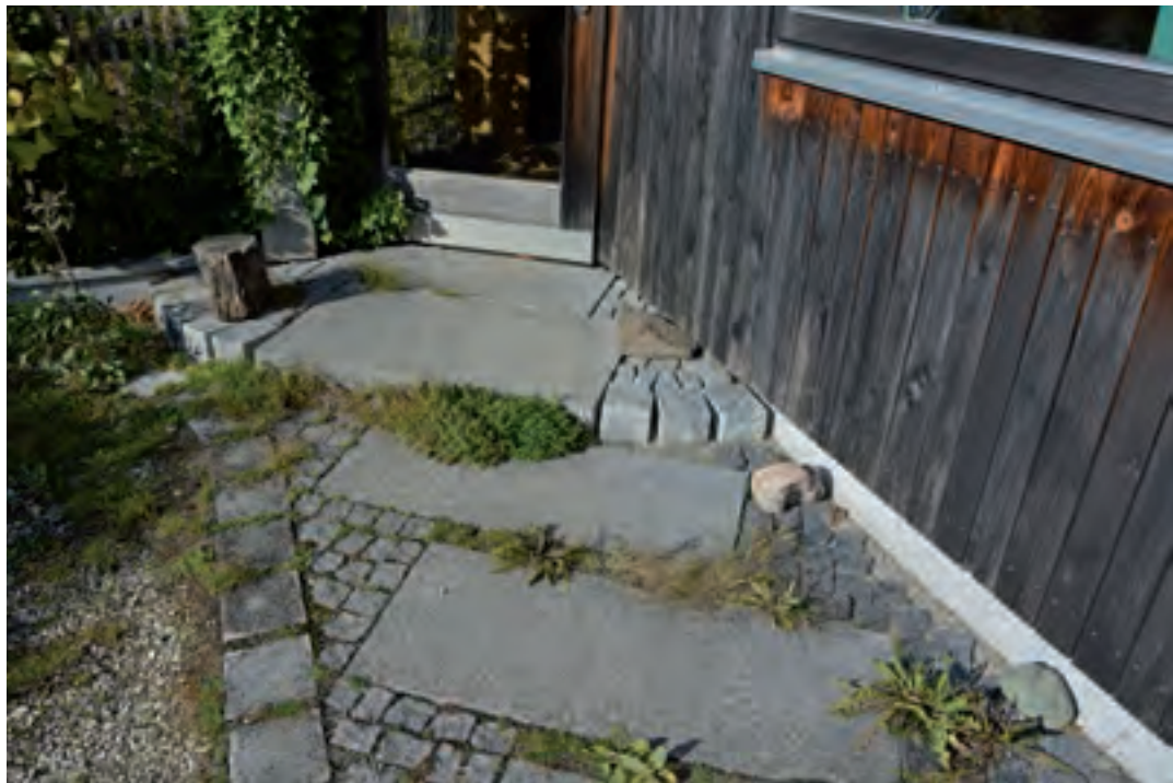
Häufig frequentierter Hauszugang – Granitplatten mit begrünenden Pflasterfugen
