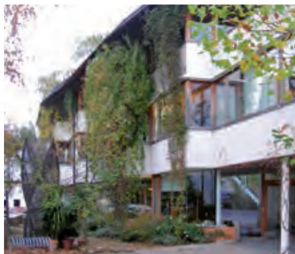
Punktuelle Begrünung einer Fassade mit Waldrebe (Clematis) an Rankhilfen
