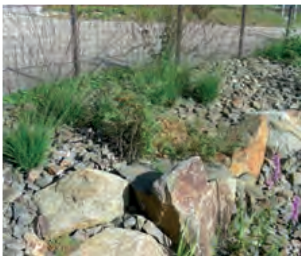
Raue Blocksteinsetzung aus Gneis als Böschungssicherung
