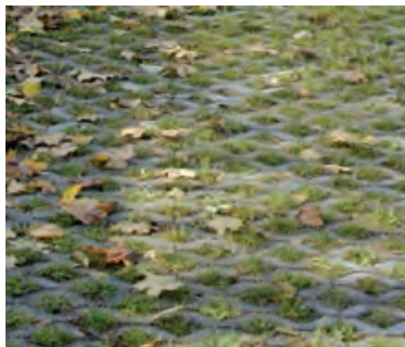
Rasengittersteine aus Beton – die Zwischenräume werden mit sandig-magerem Substrat befüllt und eingesät.
