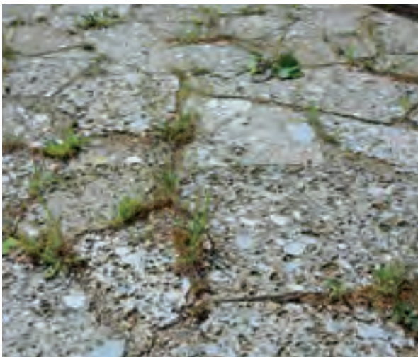
Unregelmäßige Polygonalplatten aus Konglomerat ergeben unregelmäßige Fugen, die von zahlreichen Kräutern und Wildbienen besiedelt werden.
