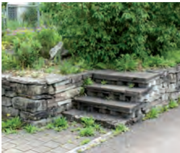
Legstufen aus Recyclingmaterial: Betonplatten auf Steinwürfeln
