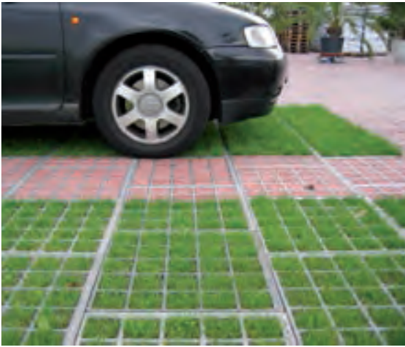
Rasenplatten aus Recycling-Kunststoff – die quadratischen Felder können wahlweise mit Rasen oder Betonpflaster gefüllt werden.
