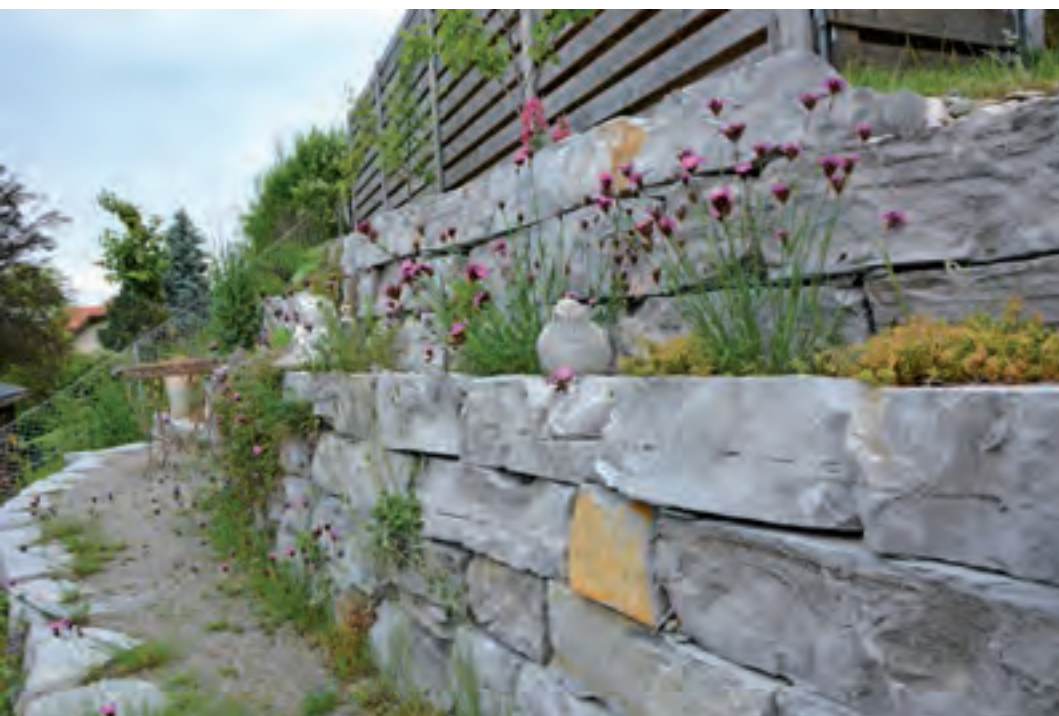
Stufenförmig versetzte Trockenmauer aus grauem Schichtkalk mit Kartäuser- nelke und Mauerpfeffer
