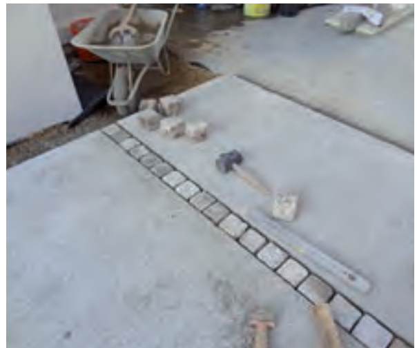
Ortbetonplatten mit breiten Fugen, die mit Natursteinpflaster gefüllt und mit Splitt verfugt werden.
