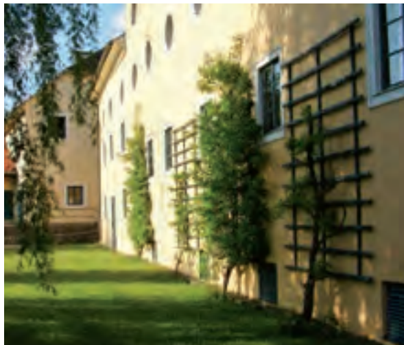
Spaliere für Obstbäume gliedern die Fassade, unter dem schützenden Dachvorsprung
