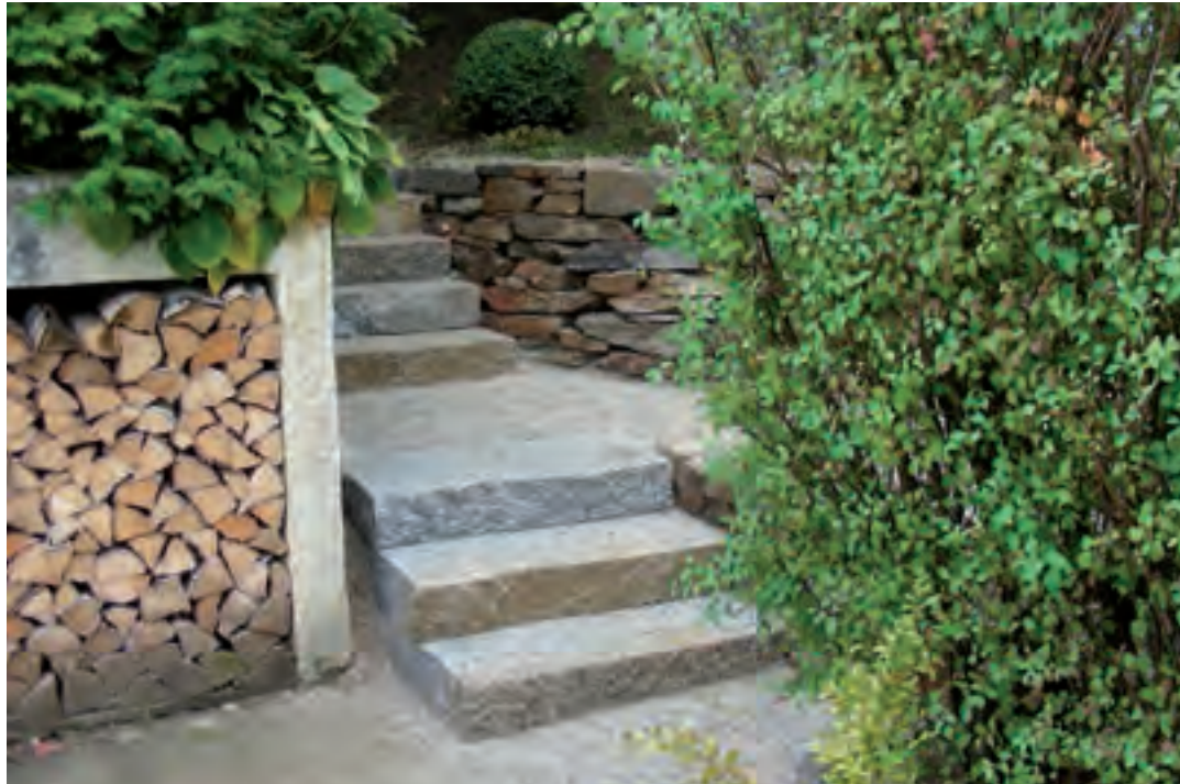
Blockstufen aus Granit mit bruchrauen Vorderkanten und sandgestrahlter Oberfläche
