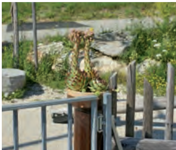
Upcycling im Naturgarten: Zaunsäule aus schottergefülltem Steingutrohr mit Hauswurz
