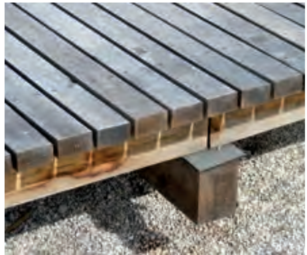
Fünf Zentimeter starke Eichenbohlen auf einer Tragekonstruktion aus Kanthölzern in Kiesbett.
