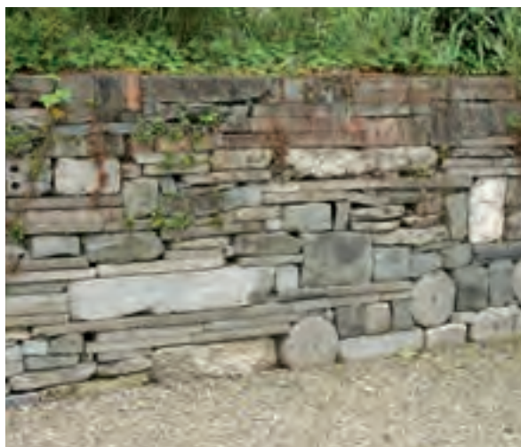
Stützmauer aus Natursteinen und vielfältigem Recyclingmaterial mit zahlreichen Hohlräumen
