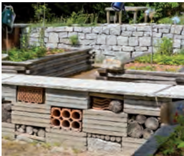
Sitzmauer aus wiederverwendeten Waschbetonplatten mit integrierten Nist- und Überwinterungsangeboten und Abdeckung aus Granitplatten
