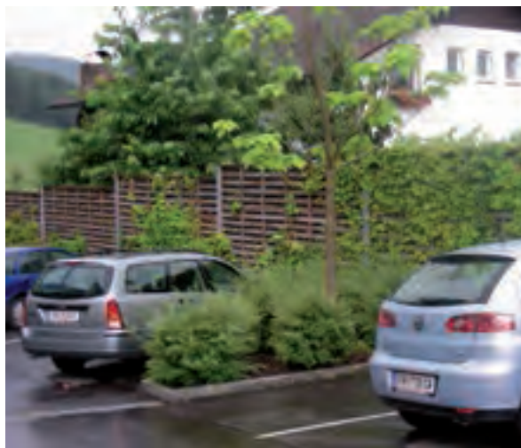
Lärmschutzwand aus Holzelementen, begrünt mit verschiedenen Schlingpflanzen
