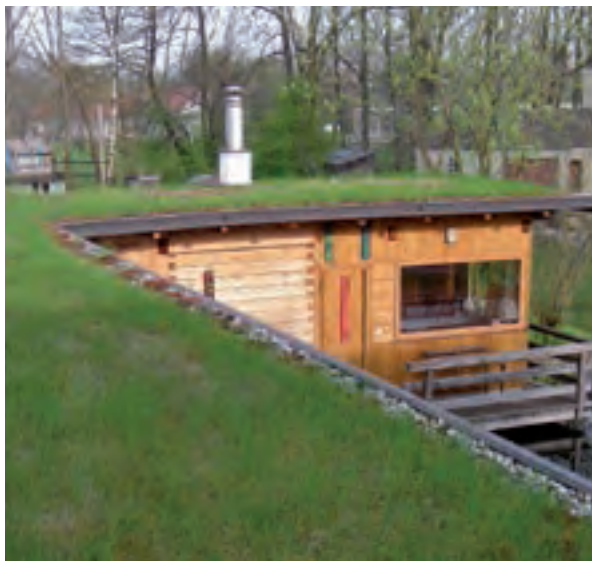
Extensive Begrünung auf dem Flachdach über dem Nebengebäude
