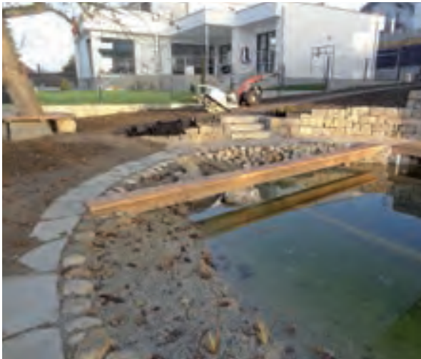
Randausbildung: Die Folie ist zwischen Trittplatten und Kieselsteinen unsichtbar befestigt.
