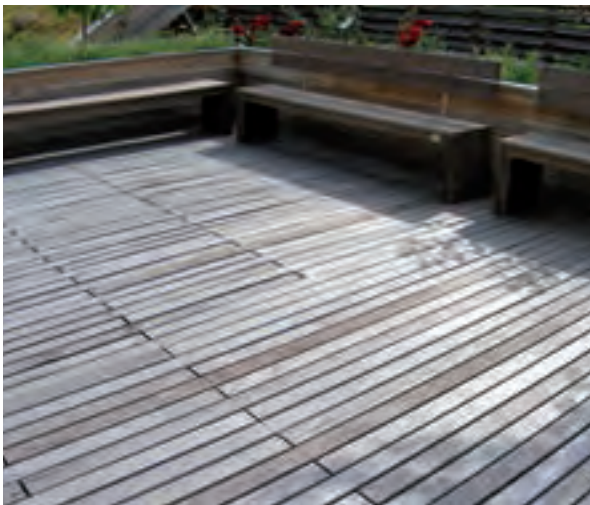
Terrasse aus unbehandeltem, silbergrau verwittertem Eichenholz mit versetzt angeordneten Stoßfugen.
