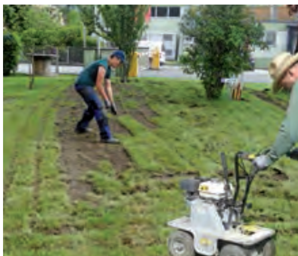
Abtrag der Grasnarbe mit dem Sodenschneider, die Soden werden aufgerollt und verwertet.
