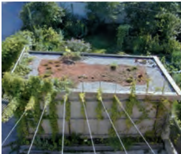
Sanierung eines alten Garagendaches mit Kautschukfolie und Extensivbegrünung einige Wochen nach Fertigstellung
