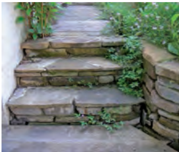
Stiege mit Legstufen aus Sandsteinplatten in gebundener Bauweise mit zurückgesetzten Mörtelfugen.
