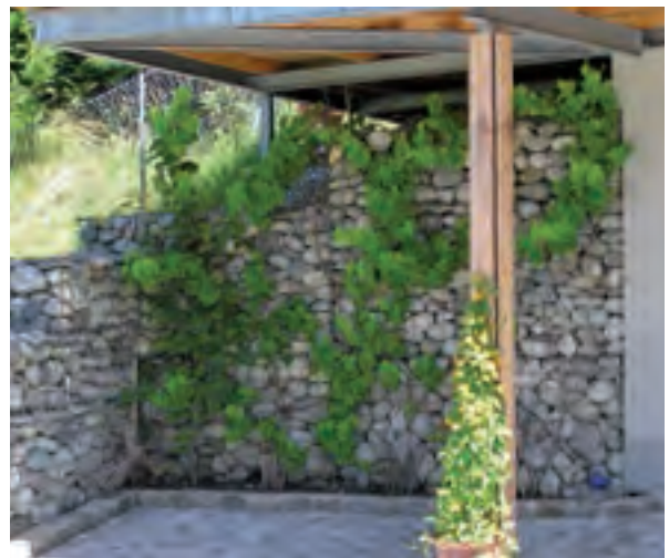
Gabionenwand mit Flusskieseln als Hangabstützung, vom Mauerfuß her mit Wein begrünt
