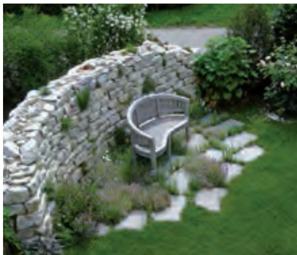
Trockenmauer aus lagerhaften Kalksteinen mit leichter Neigung (Anzug) und bepflanzten Fugen
