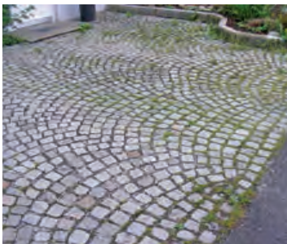
Hauszugang und Garageneinfahrt aus Granitpflaster – in den Fugen siedeln sich Moose und trittfeste Pflanzen an.
