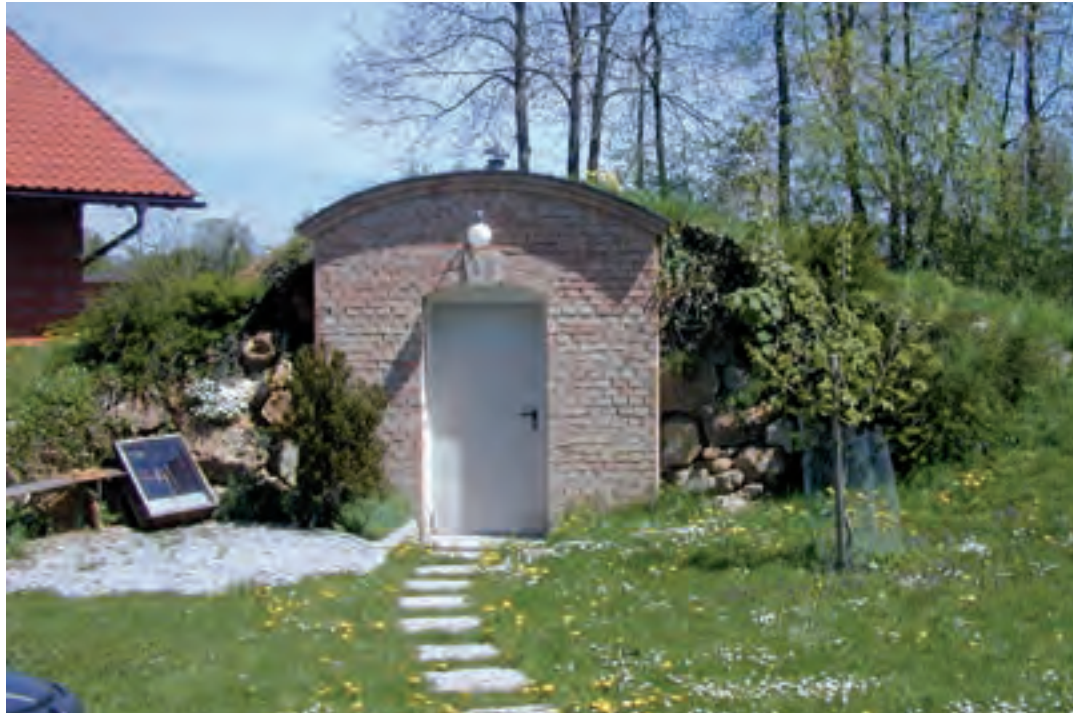
Erdkeller- in den Garten integriert durch den sanft ansteigenden, mit Wiese begrüntem Hügel
