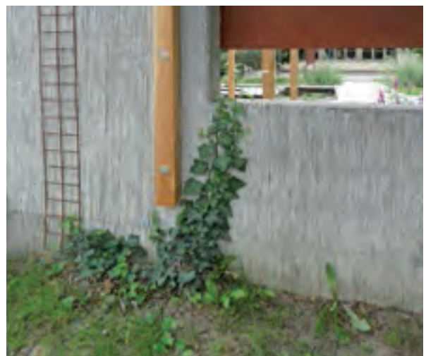
Betonmauer mit bewuchsfördernd strukturierter Oberfläche durch Einlage von Schilfmatten in der Schalung
