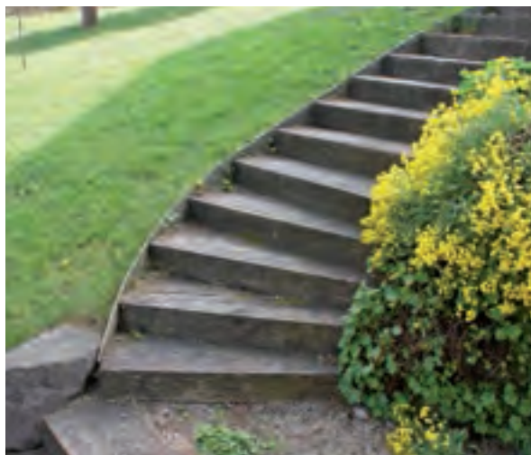
Holzblockstufen aus Eichenholz
