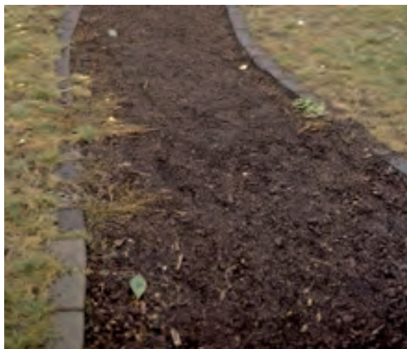
Fußfreundlicher Weg aus Rindenmulch mit einer Begrenzung aus Leistensteinen
