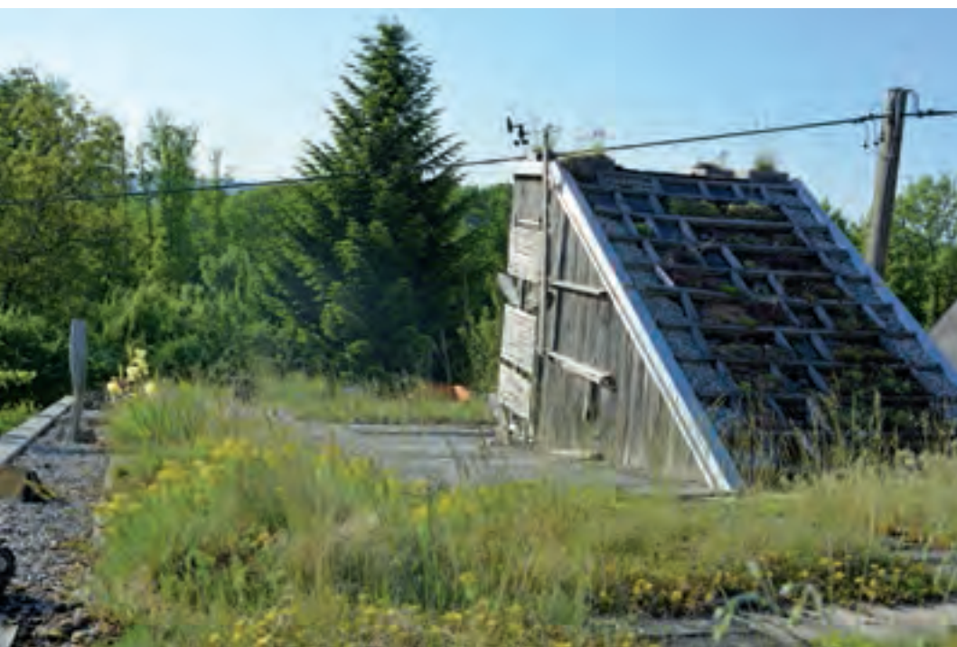
Gründach – attraktiver Lebensraum mit Holzdeck und vielfältigem Bewuchs auf wenigen Zentimetern Ziegelsplittsubstrat
