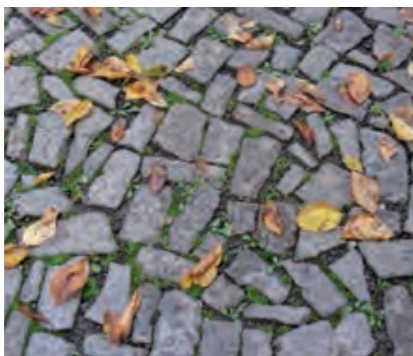
Wildpflaster aus unsortierten Bruchsteinen. Die unterschiedlichen breiten Fugen ermöglichen eine große Pflanzenvielfalt.
