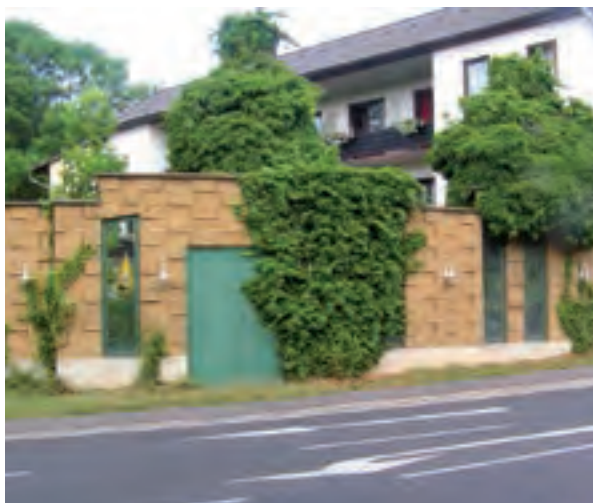
Lärmschutzwand aus Holzbeton-Fertigteilen, begrünt mit selbstkletternder Mauerkatze ( Parthenocissus tricuspidata „Veitchii“)
