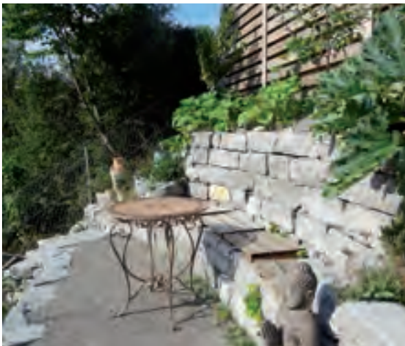
Geschichtete Trockenmauer aus lagerhaften Kalkblöcken mit integrierter Sitzbank
