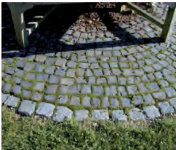
Kleinsteinpflaster in Splitt verlegt und mit Sand verfügt – schon nach zwei Jahren haben sich die Fugen mit Moos begrünt.
